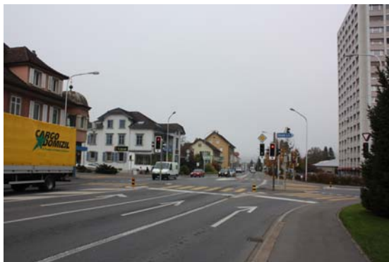
Zu hohe Verkehrsbelastung im Bereich Hochhauskreuzung
